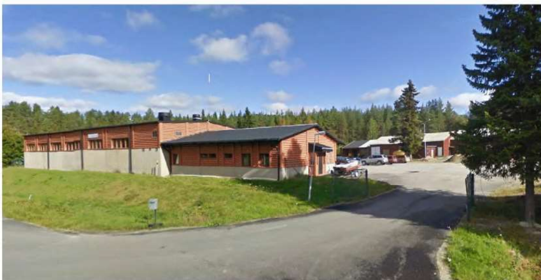
Figur 6. Byggnader på intilliggande fastighet Förrådet 1.
